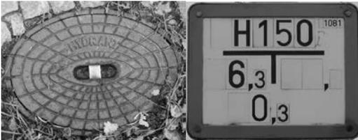
Woher erkenne ich, wo sich ein Hydrant befindet? Das ist ganz einfach: Die Hinweisschilder von Hydranten sind weiße, rechteckige Schilder mit einem breiten roten Rand (siehe Foto). Die Zahlen auf dem Schild geben an, in welcher Entfernung in Metern sich der Hydrant nach vorn, links oder rechts befindet. In unserem Beispiel befindet sich der Hydrant 0,3 Meter vor dem Schild und 6,3 Meter links davon. Den Hydranten an sich erkennt man an der ovalen Metallplatte mit der Aufschrift „HYDRANT“.
